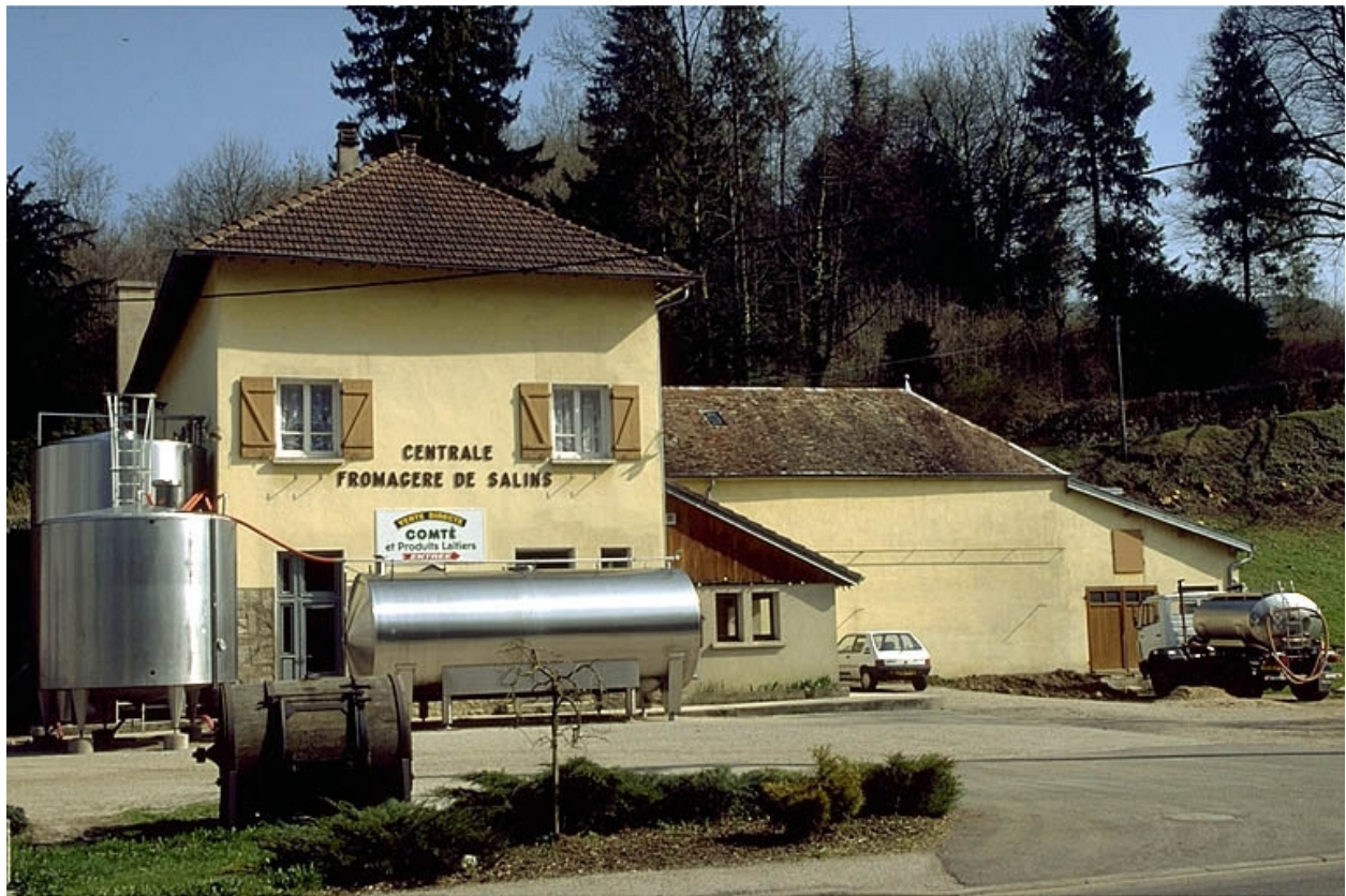
Façade antérieure depuis la route.
