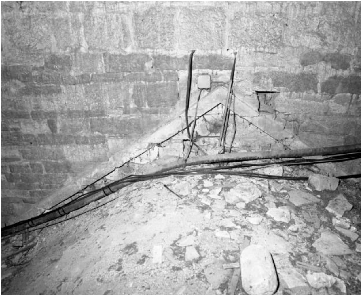
Rampants du pignon de l'ancien toit du choeur contre le mur postérieur du clocher. Vue prise dans le comble du choeur.
