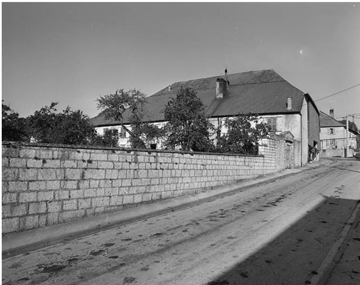
Façade antérieure et mur d'enclos.
