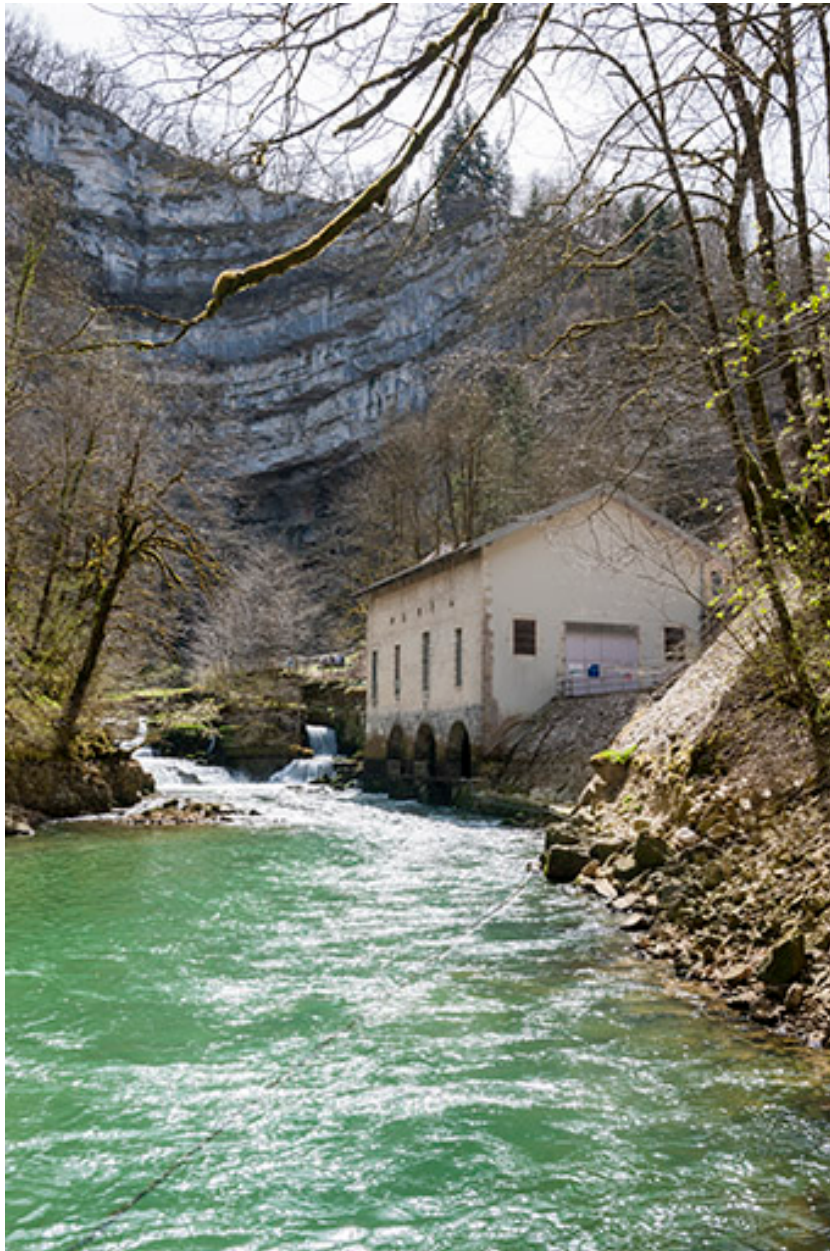
Vue d'ensemble depuis l'aval.
