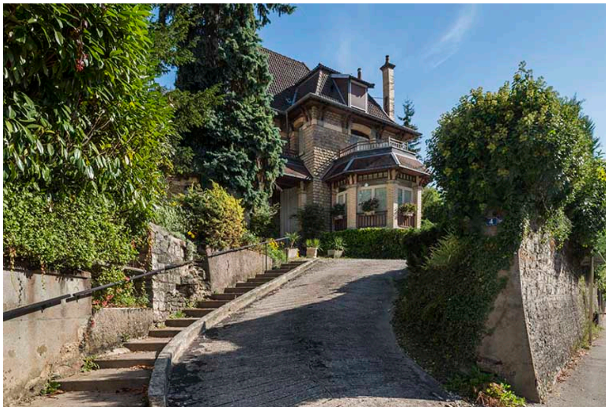
Logement patronal, depuis la rue.
