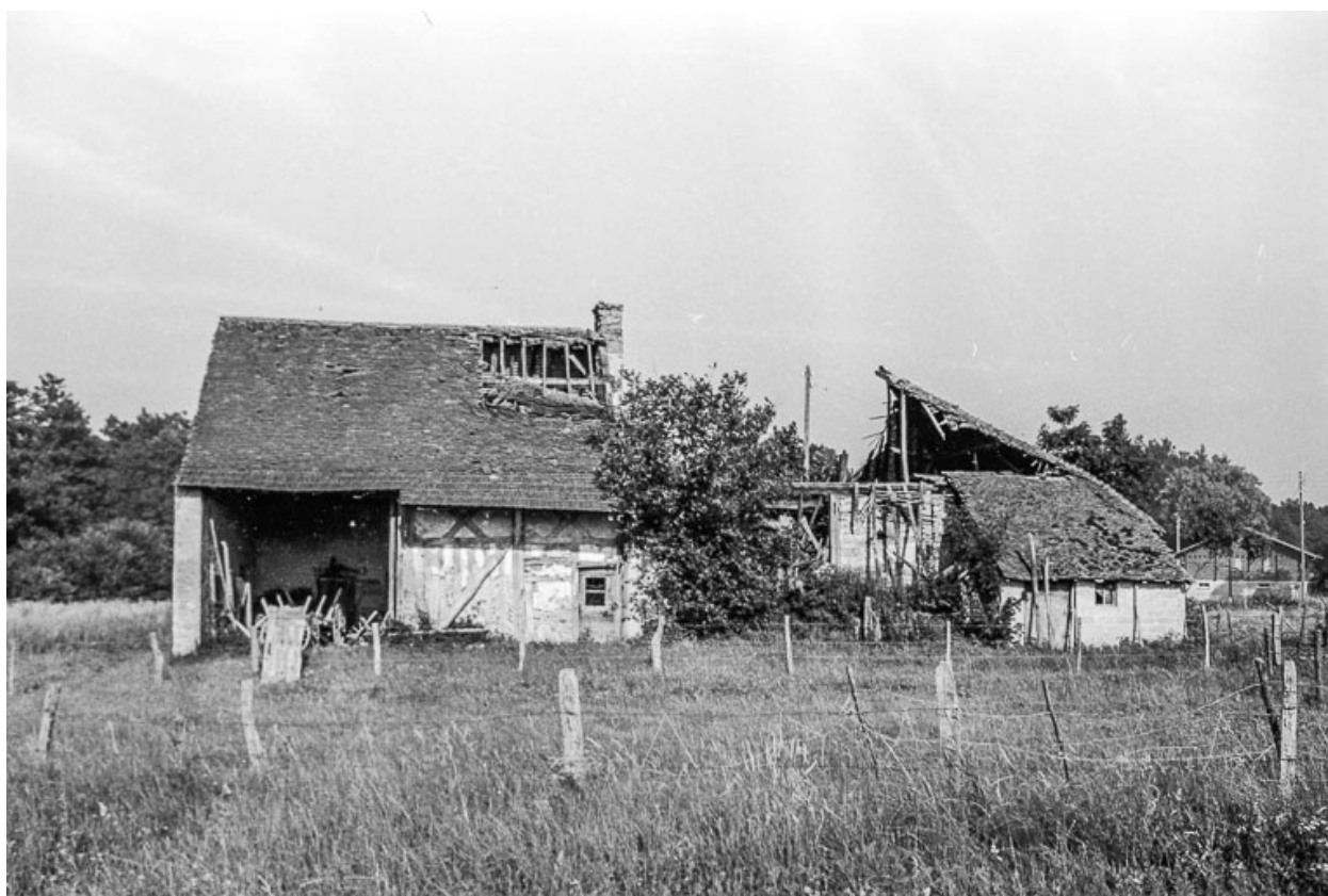
Ferme cadastrée 1956 A1 142-143 : vue générale.
