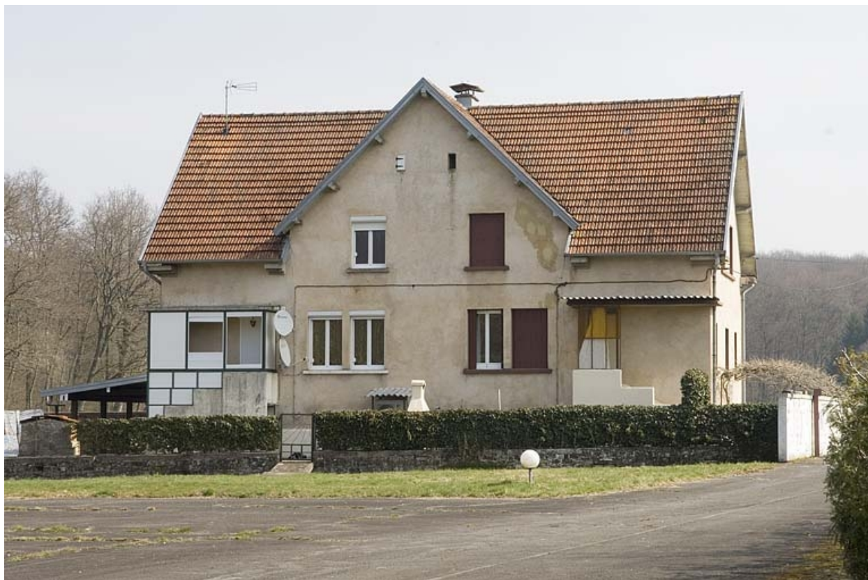
Logement de cadres (?). Façade postérieure.
