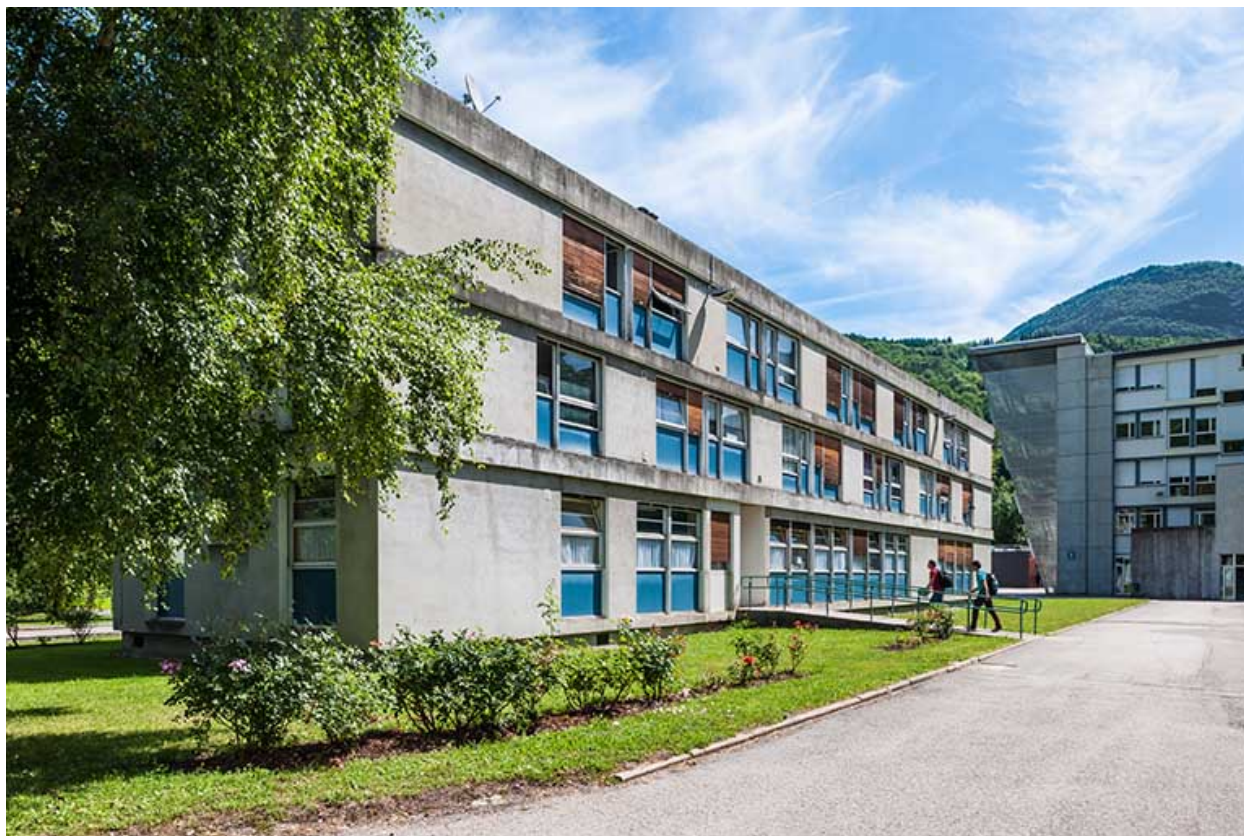
Administration : façade postérieure.
