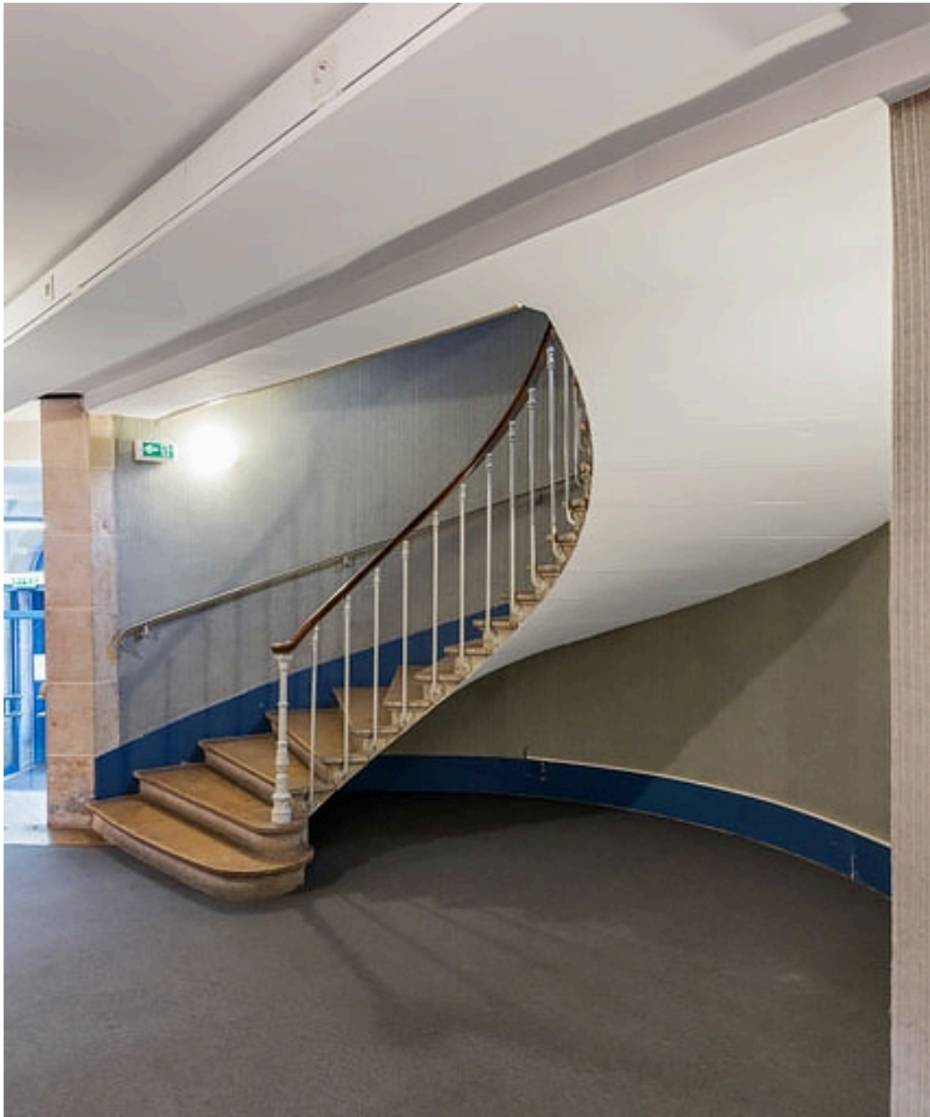
Escalier côté jardin : départ au rez-de-chaussée.
