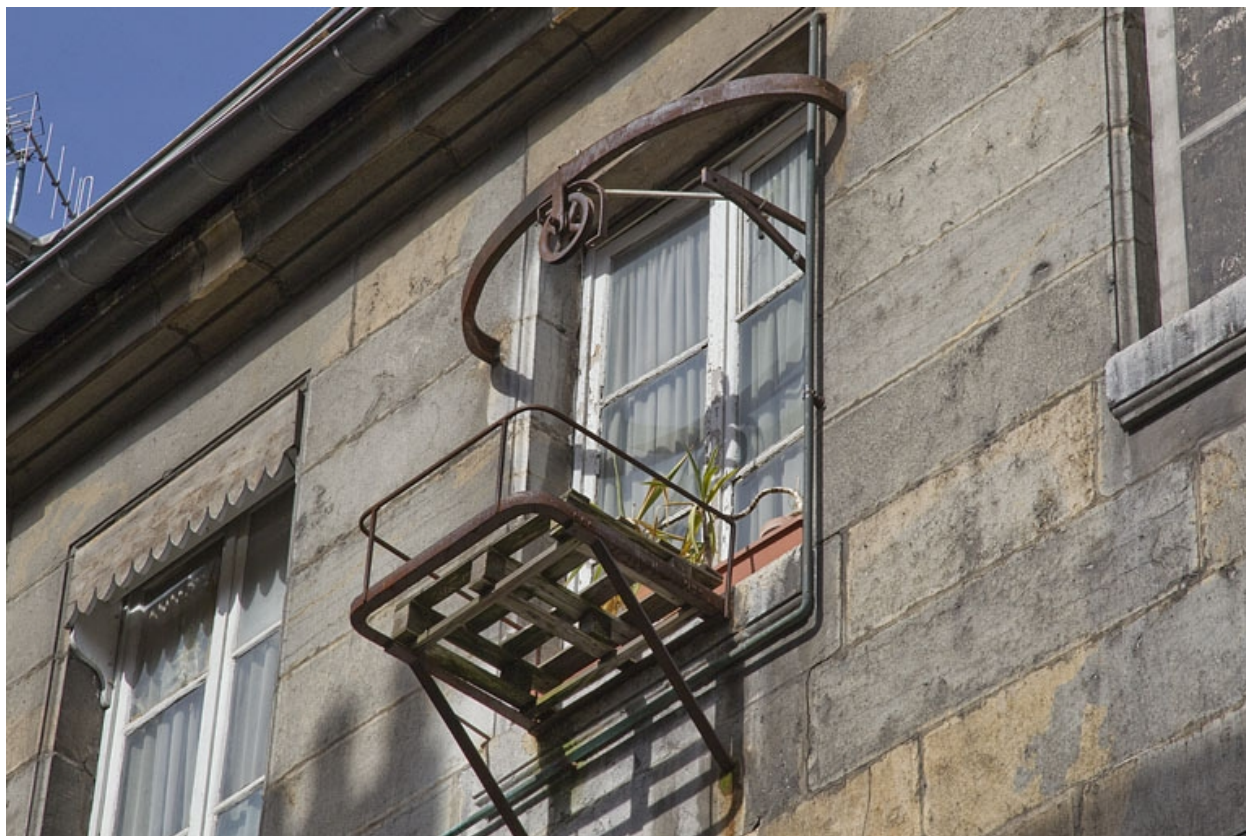
Aile gauche : détail d'un monte-charge.
