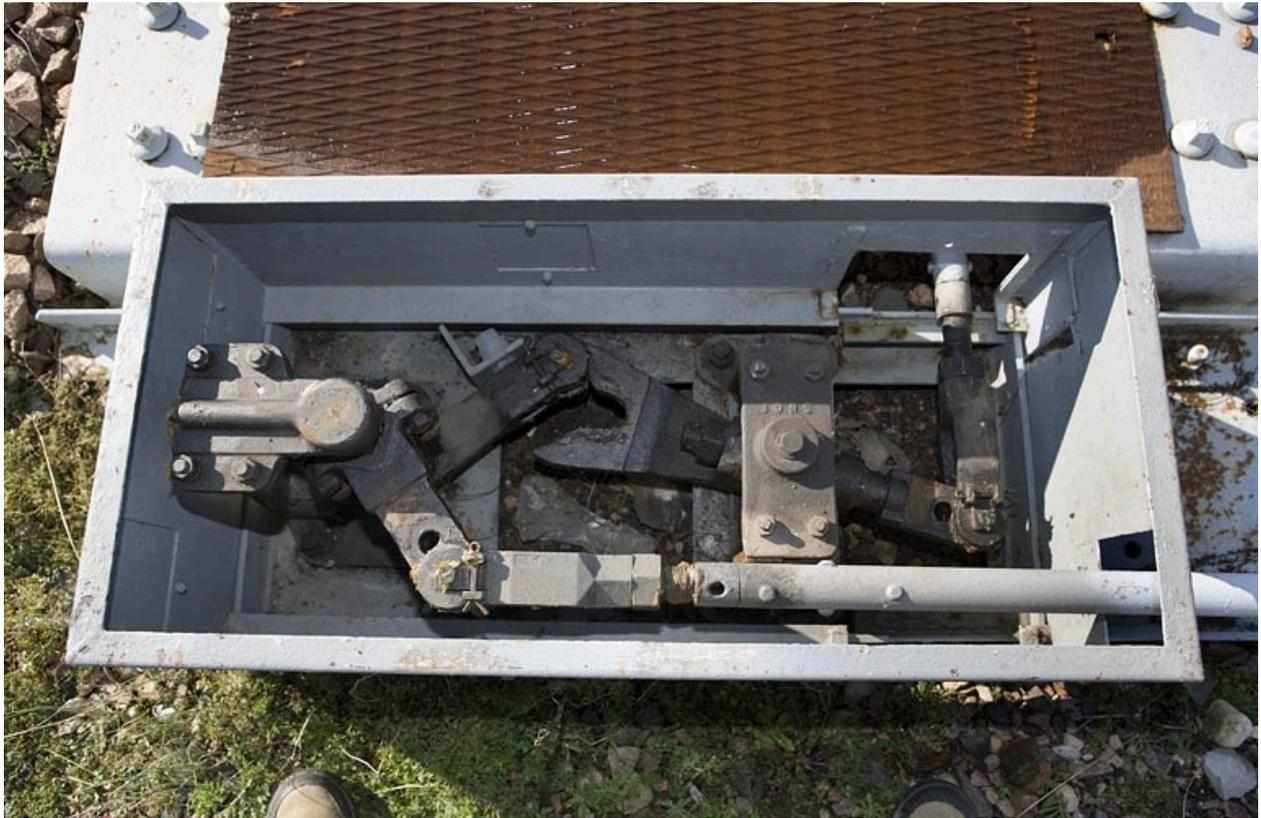
Système de renvoi d'angle. La tringle actionnant les aiguilles (en haut) est reliée à celle du levier de manoeuvre par une pièce métallique dite " pince de homard ".
