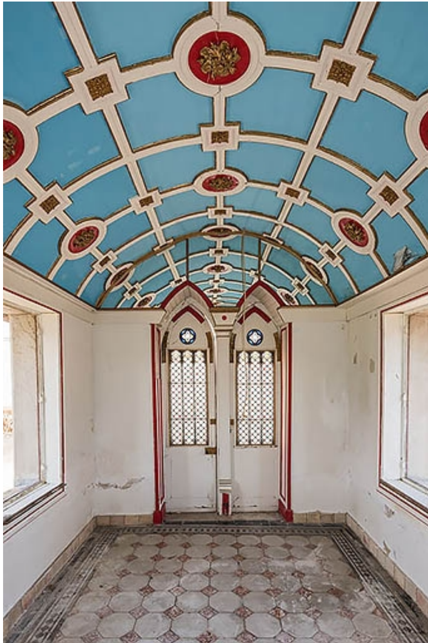
Chapelle : vue intérieure vers l'entrée.
