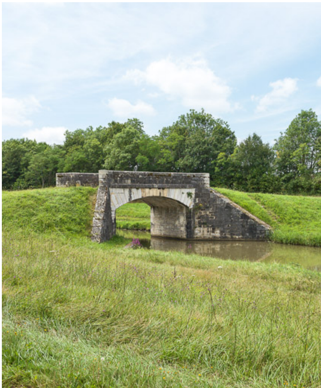
Vue du pont.
