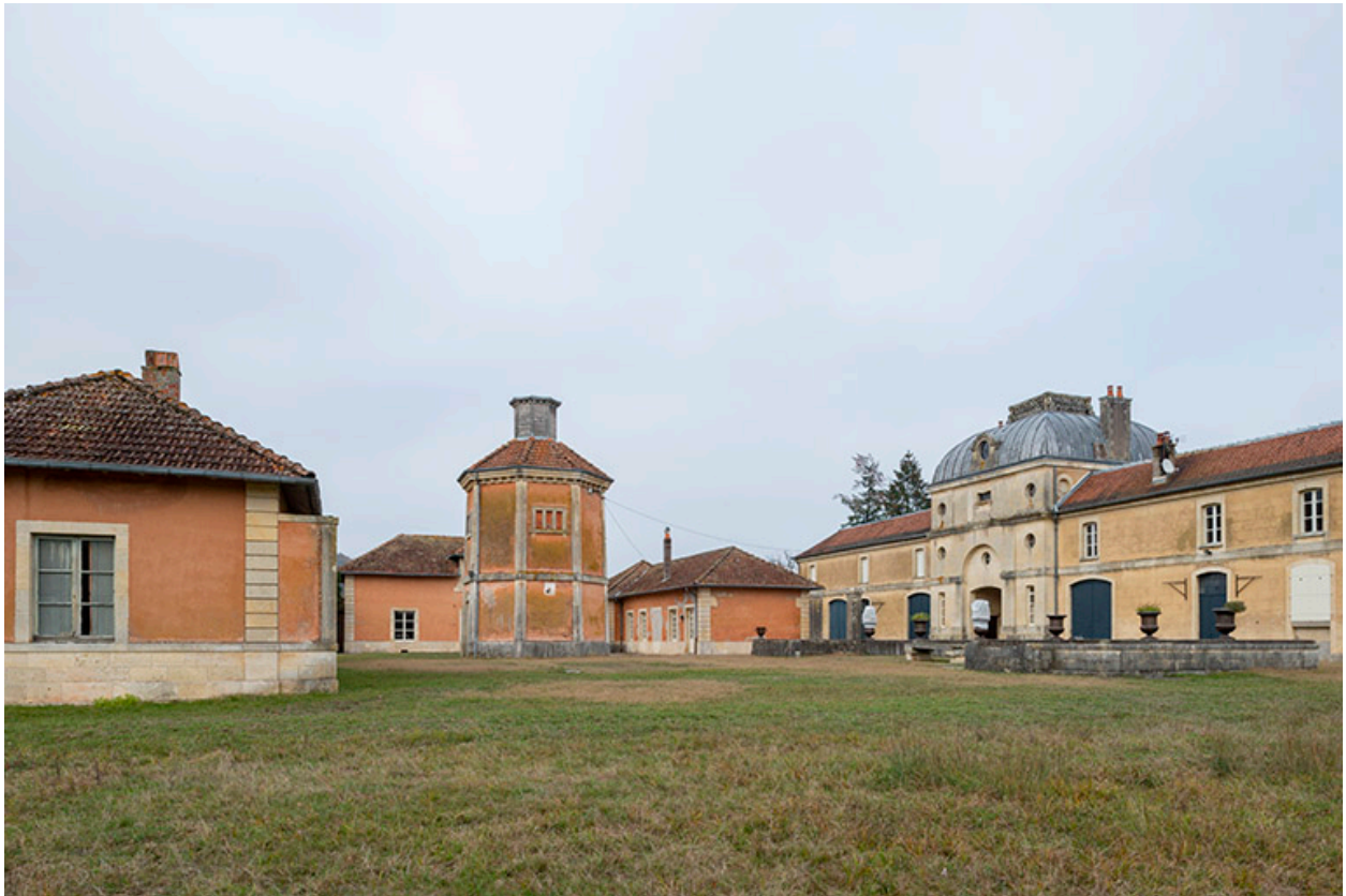
Dépendances et pigeonnier, vue d'ensemble depuis le sud-ouest.
