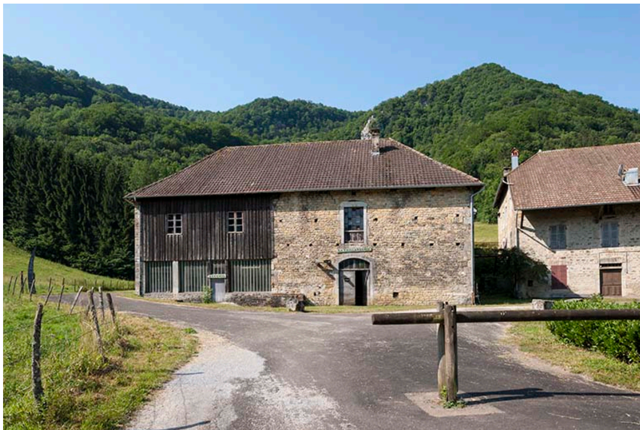
Façade antérieure de l'atelier de fabrication.
