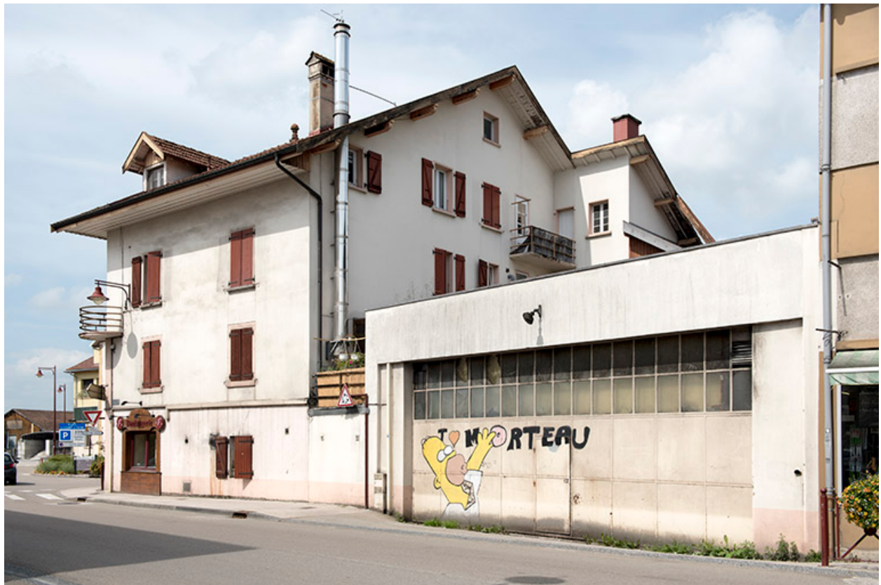
Façade latérale droite.
