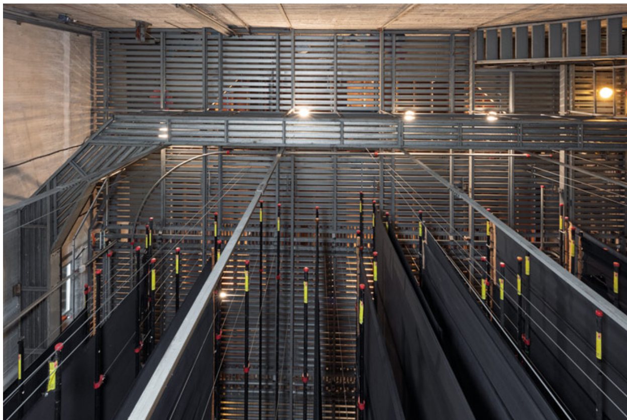
Maison de la culture, grande salle : le gril, vu depuis une passerelle technique.
