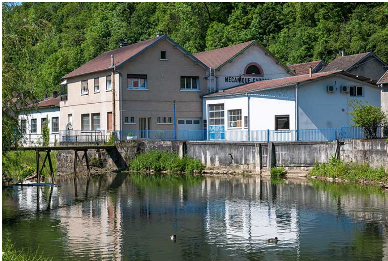
Vue du pont, depuis l'amont.
