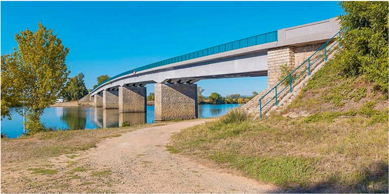
Le pont d'Ouroux, vu d'amont, depuis la rive droite.
