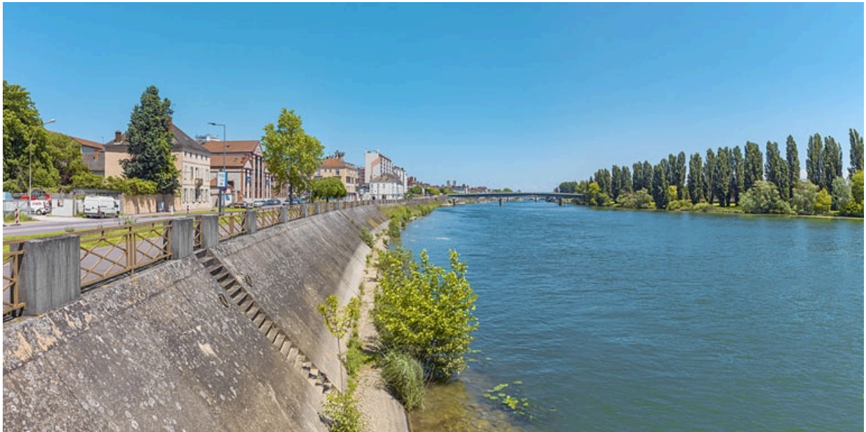
Le quai vu d'aval.
