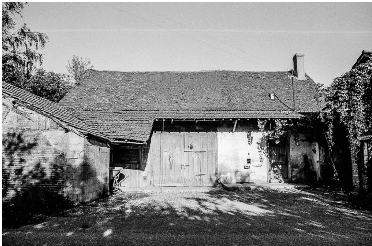
Ferme cadastrée 1949 B1 352 : façade antérieure.
