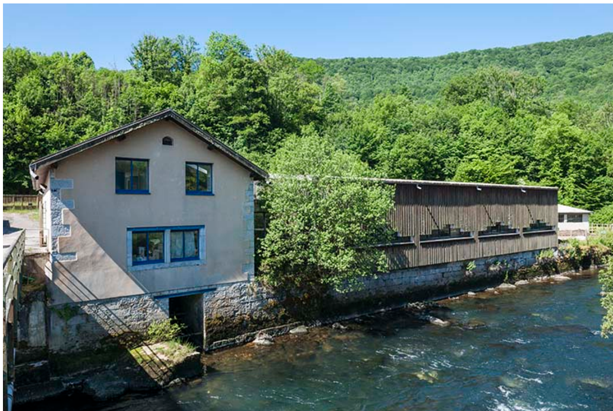
Usine du Moulin-Neuf. Bâtiments subsistants (logement ?).
