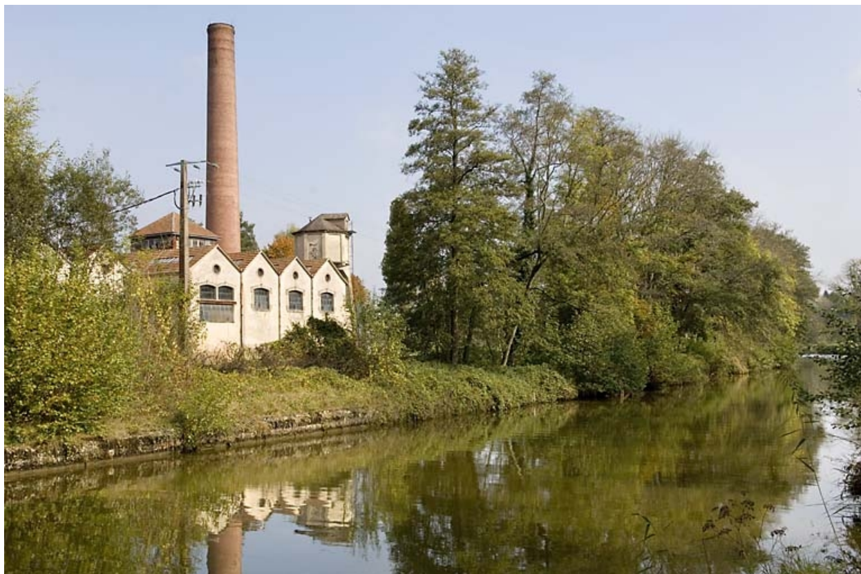
Vue d'ensemble depuis le sud du canal.
