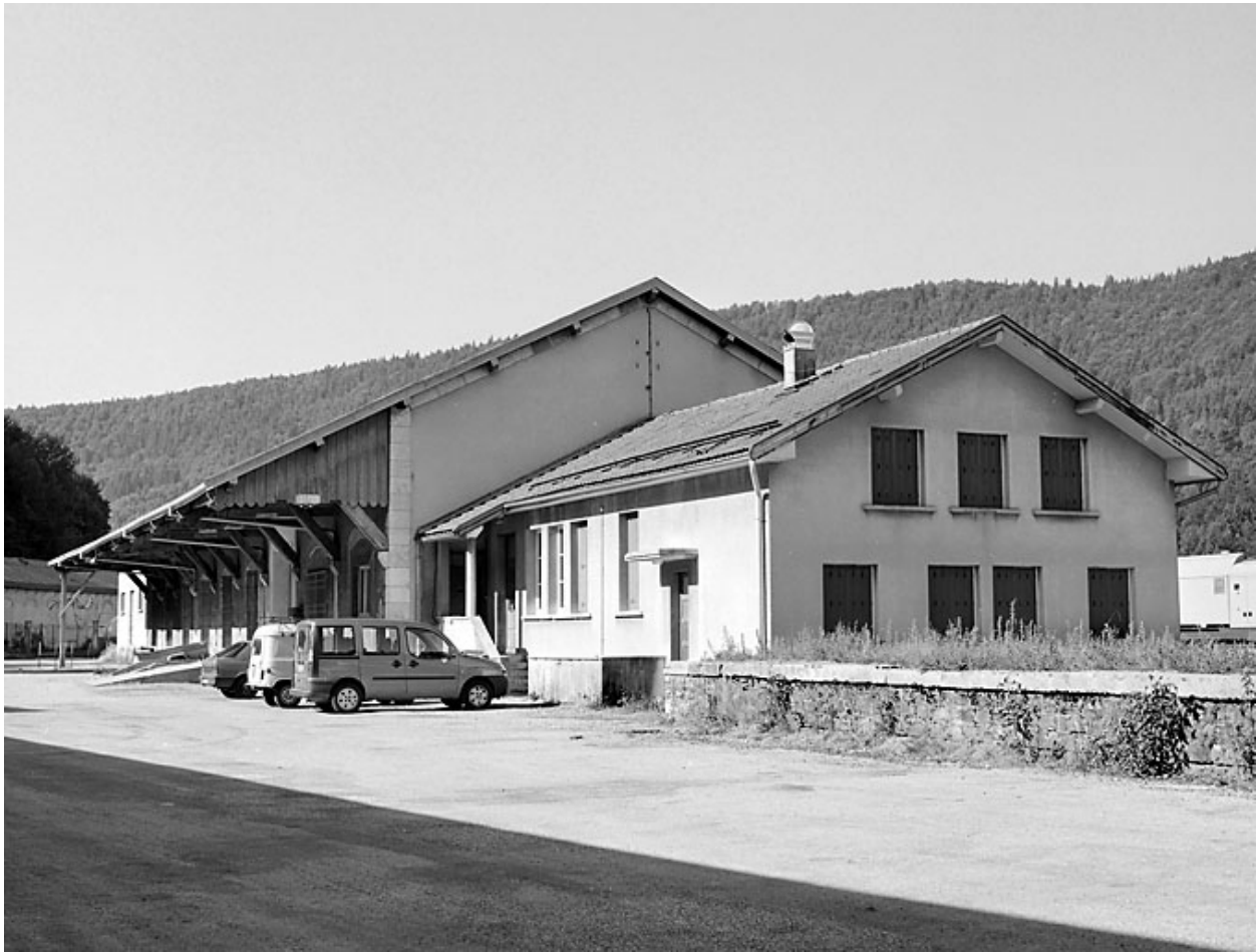
Entrepôt et ancien foyer des roulants, depuis le nord-est.
