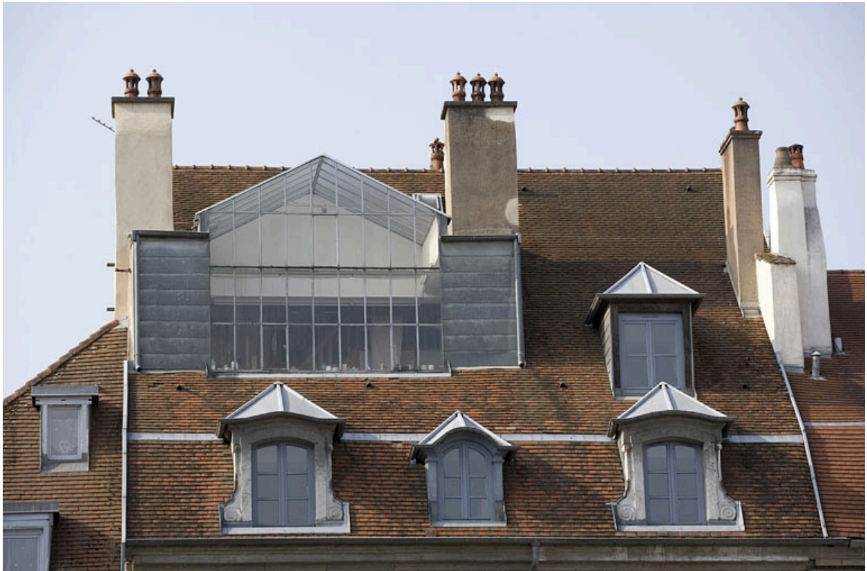
Toiture : détail de la verrière de l'atelier d'artiste.
