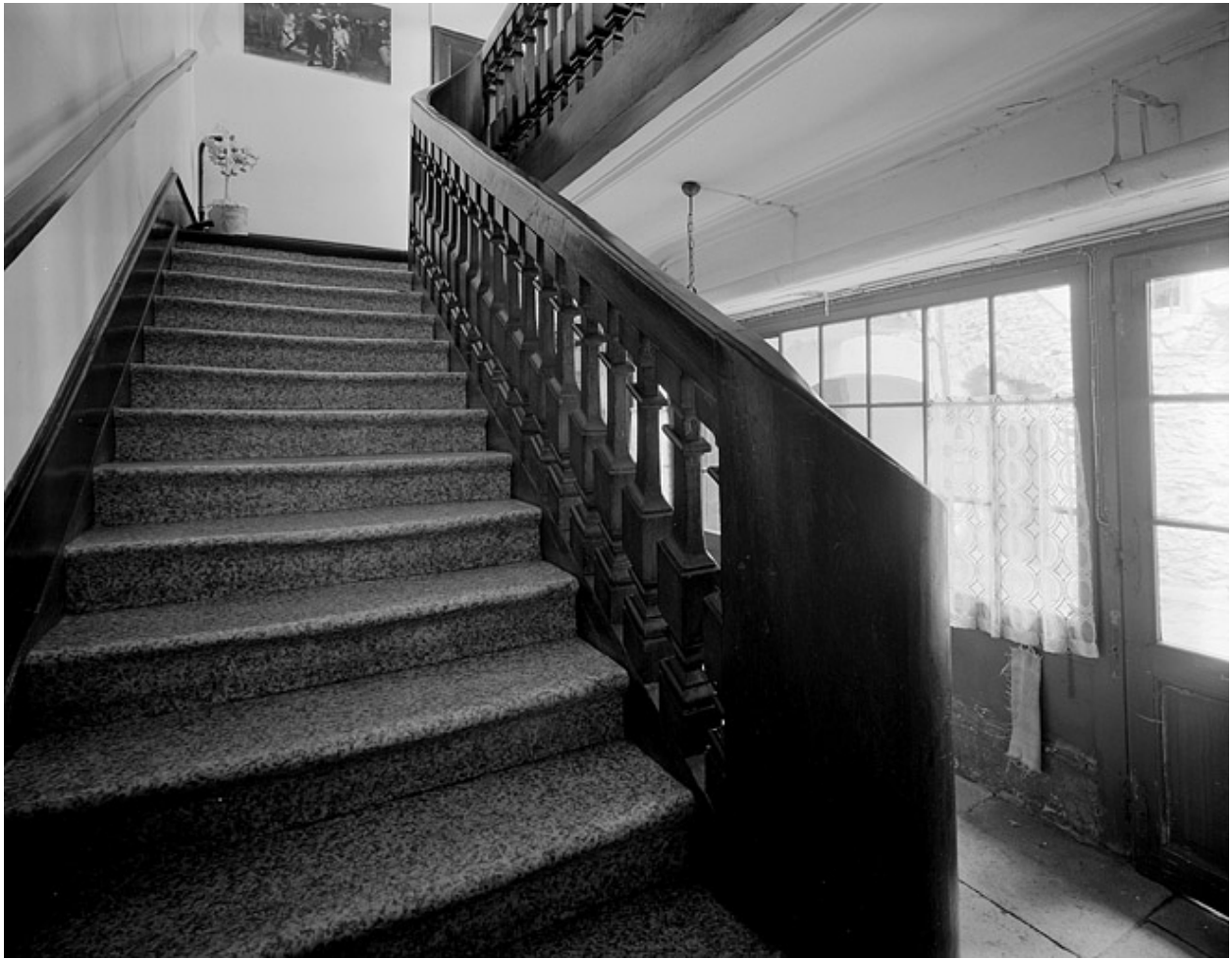
Escalier principal vu du premier repos.
