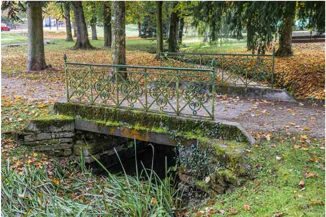
Pont à garde-corps en métal.
