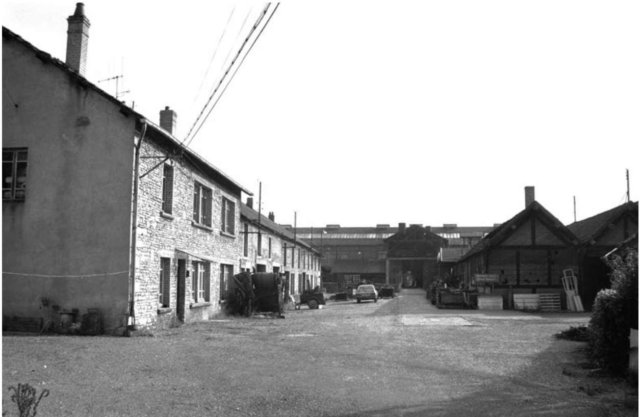
Vue d'ensemble depuis l'entrée en 1987.
