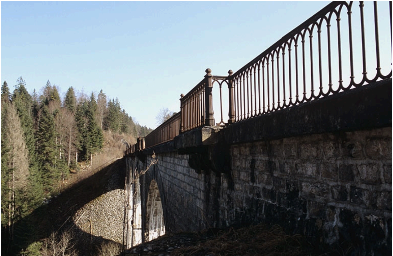
Garde-corps de l'élévation occidentale.
