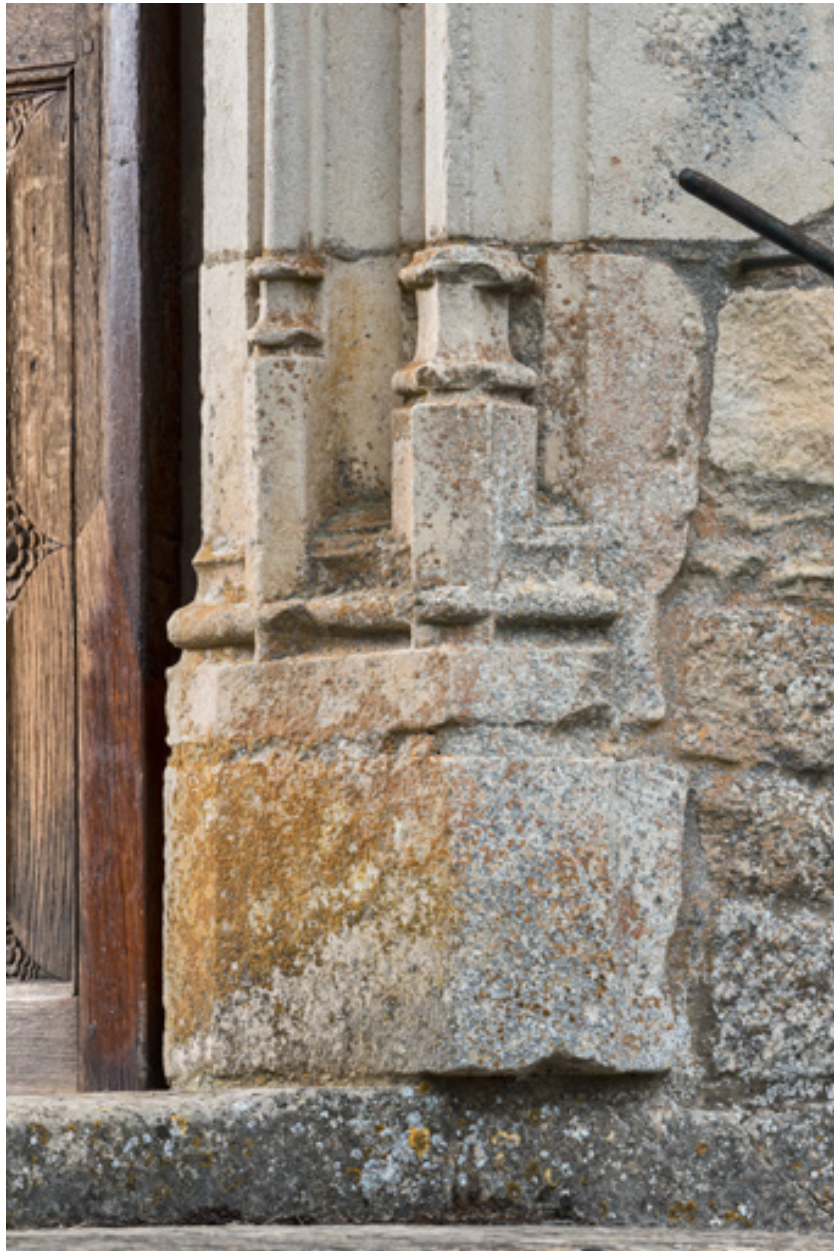
Piédroit, détail de la partie inférieure, droite.
