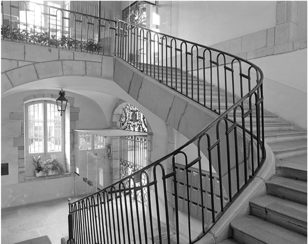
Grand escalier : dernière volée et palier.
