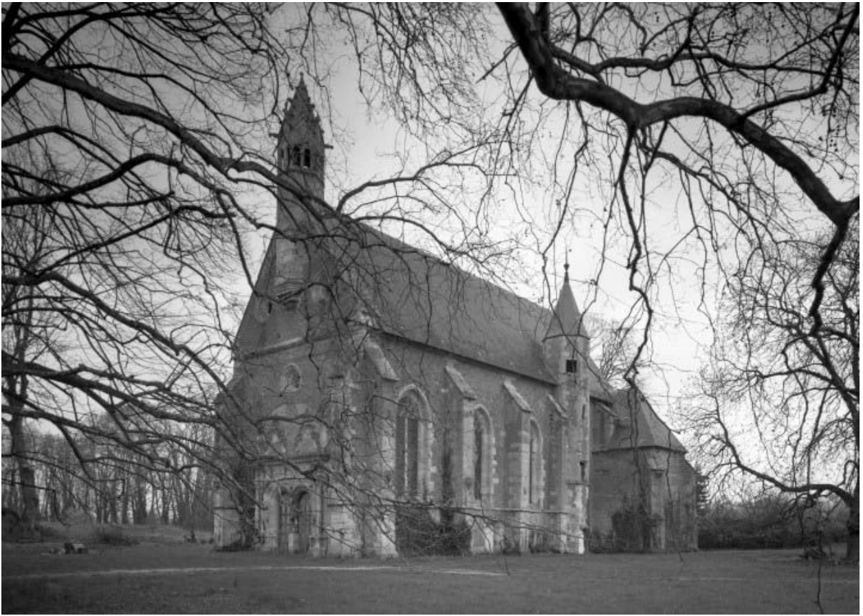
Chapelle de l'ancien château, vue d'ensemble de trois-quarts droit.
