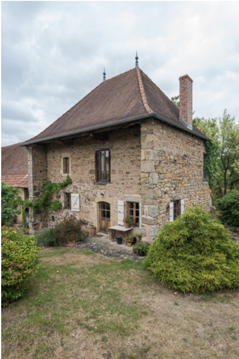
Vue des façades antérieures et latérales de la maison à l'origine de l'ensemble en alignement
