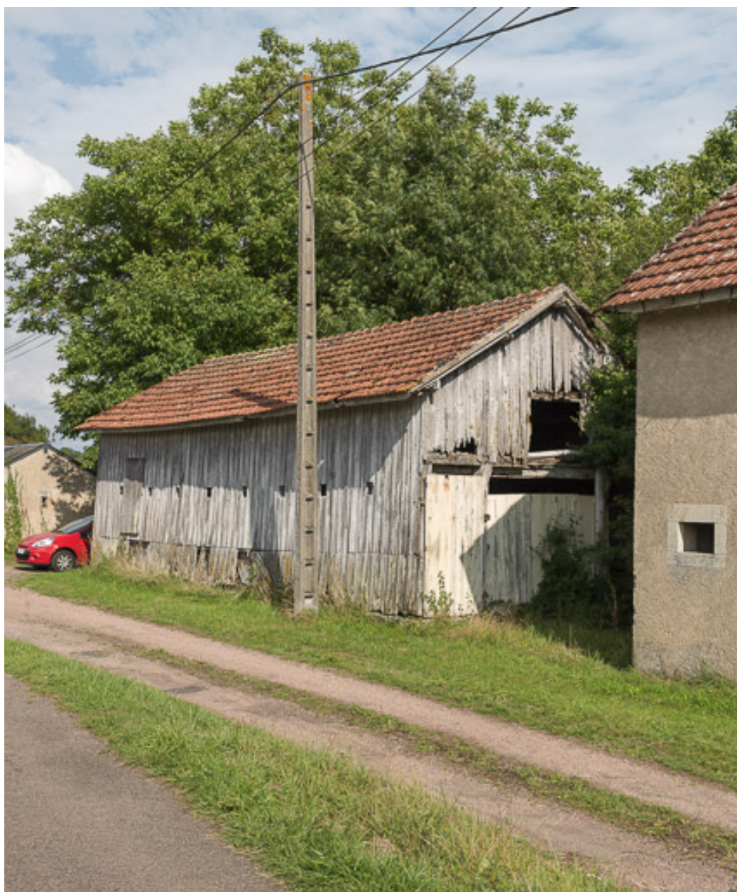
Vue de l'extension de la maison éclusière.
