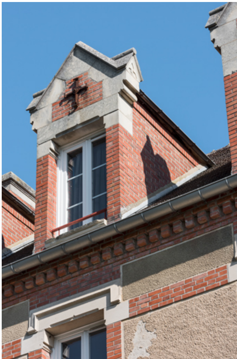
Détail des lucarnes réalisées lors de l'aménagement de l'étage sous comble.
