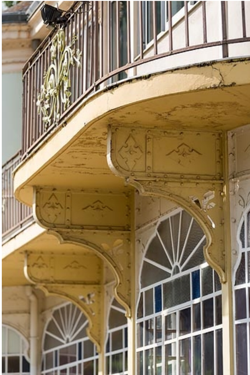
Aile ouest, salle à manger, détail.
