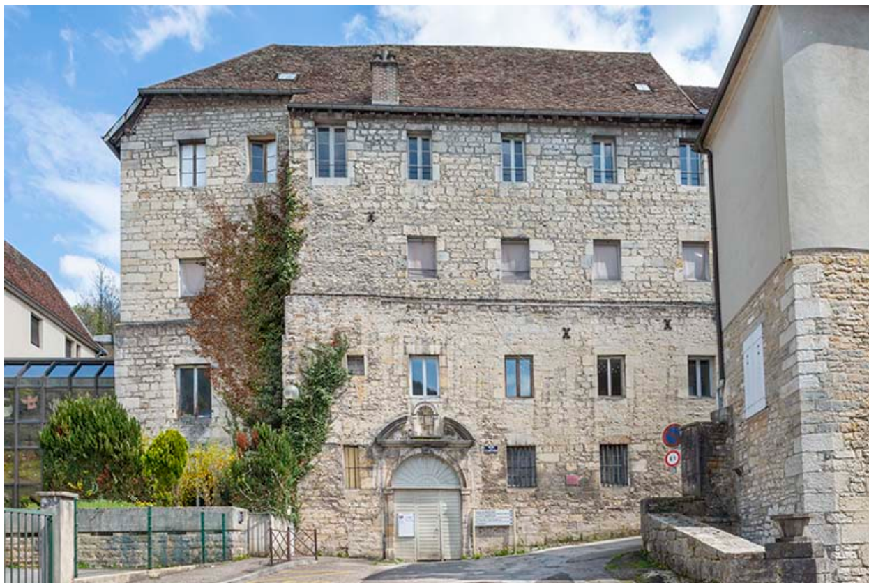
Extrémité nord du bâtiment, depuis l'ouest.
