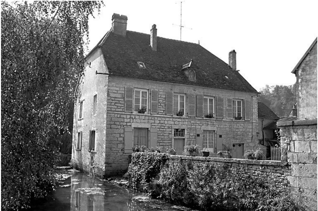
Façade antérieure de l'habitation.
