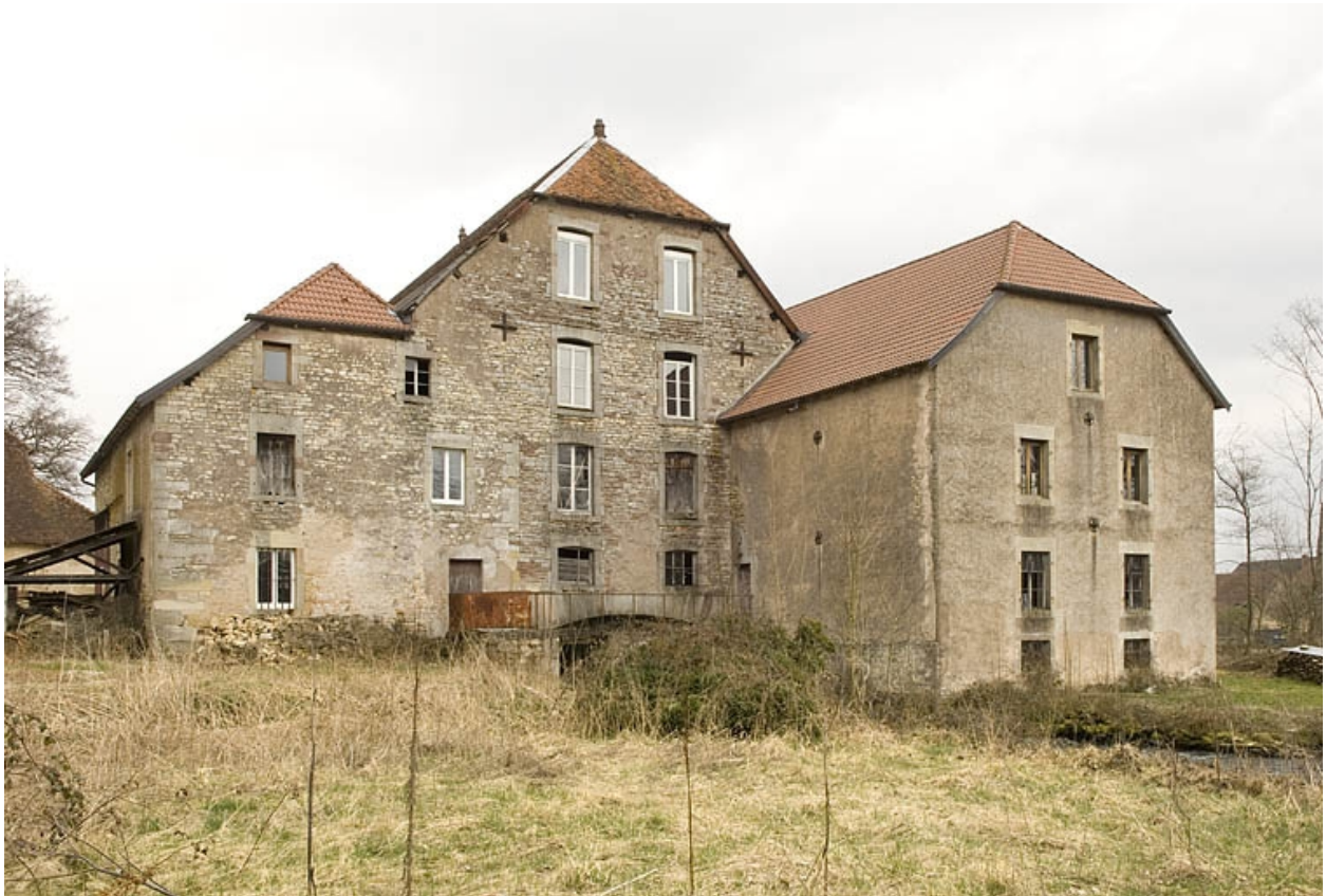
Vue de trois quarts, depuis l'ouest.
