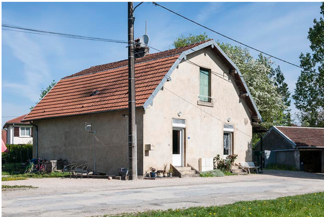
Logement ouvrier double (4 allée des Rompeux).
