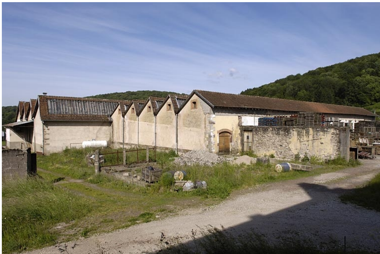
Les ateliers de filature vus depuis l'est.
