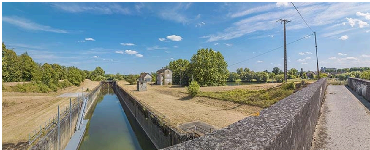
Vue d'ensemble du site d'écluse depuis la passerelle.
