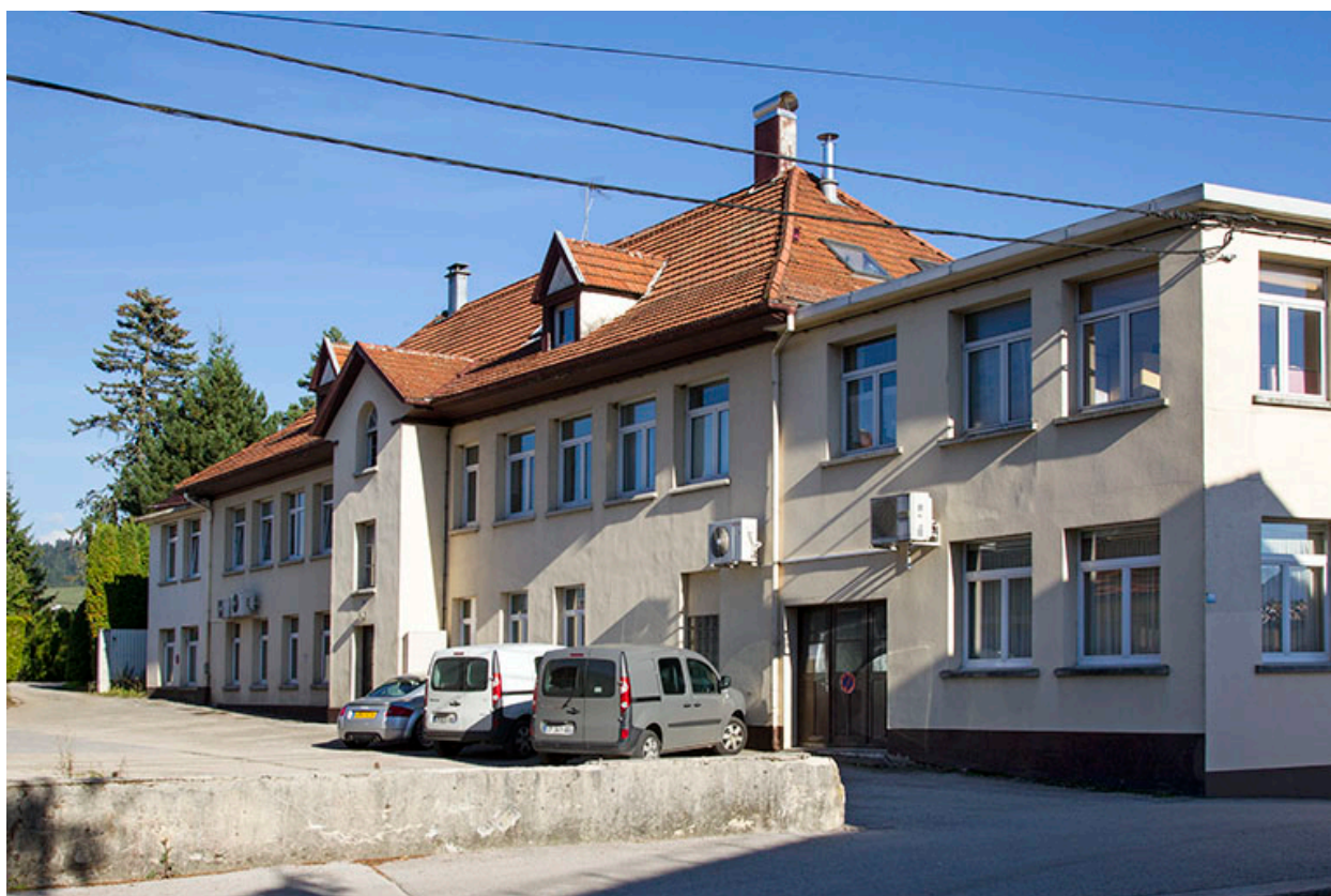
Usine : façade postérieure, de trois quarts droite.
