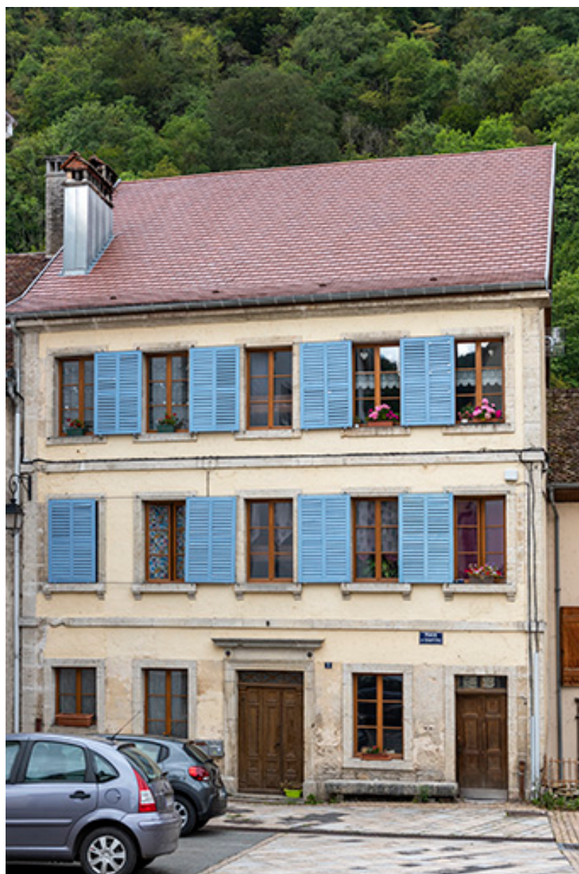
Immeuble 3 place du Chapitre : façade antérieure.
