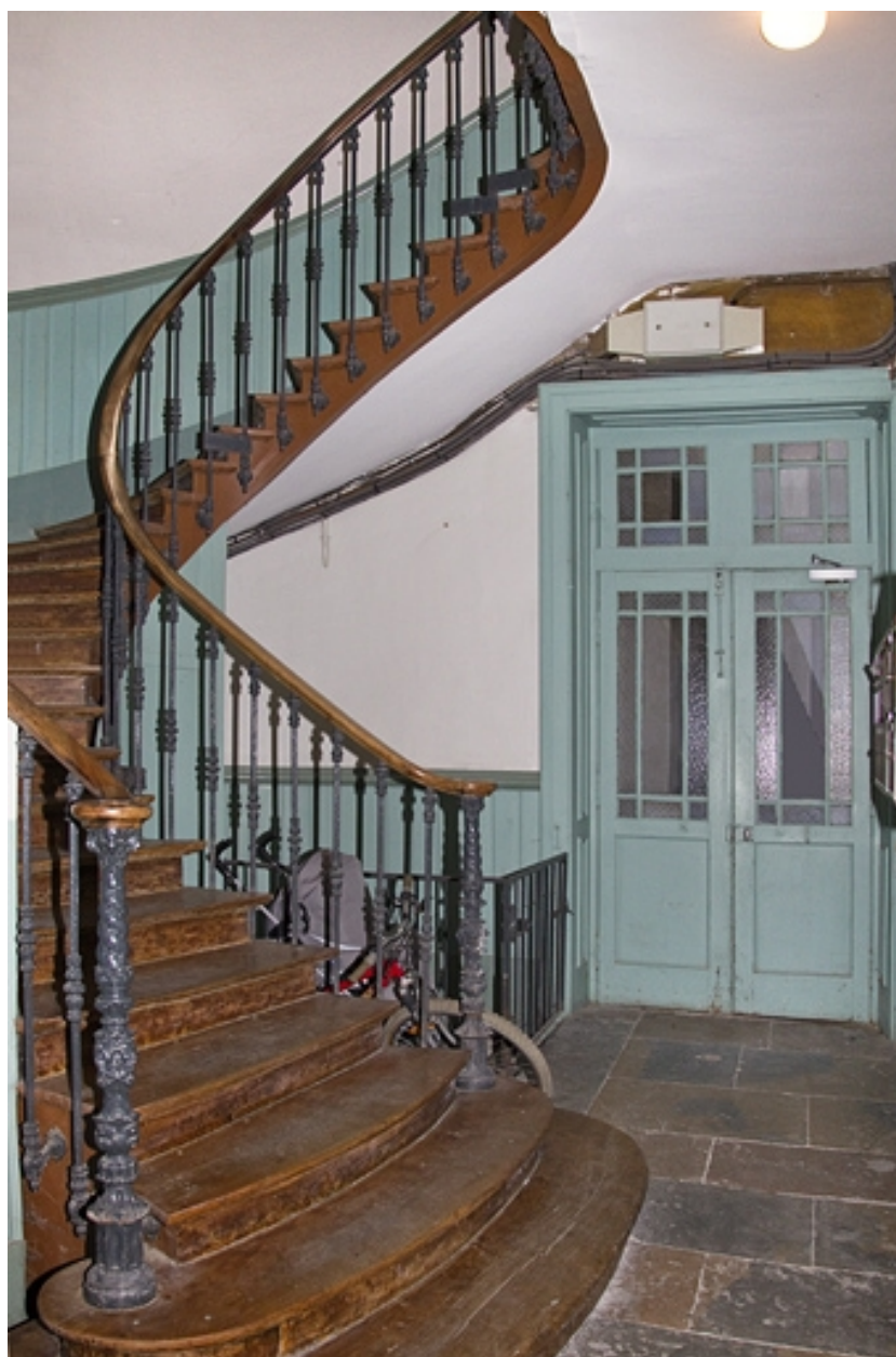
Intérieur : vue d'ensemble de l'escalier.
