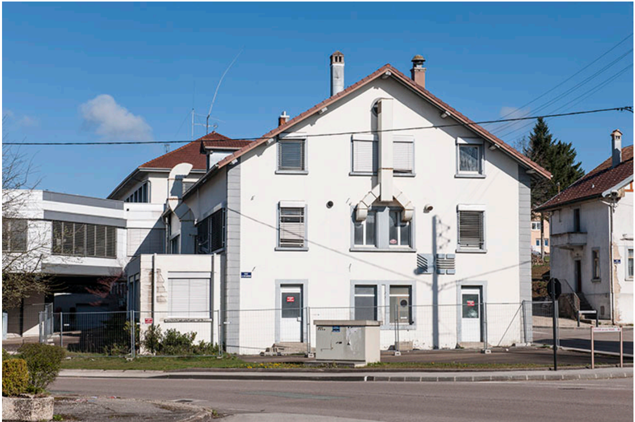
Usine, 1er corps de bâtiment : façade latérale gauche.
