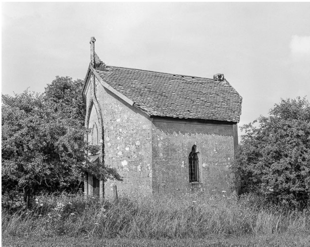
Façade latérale droite.
