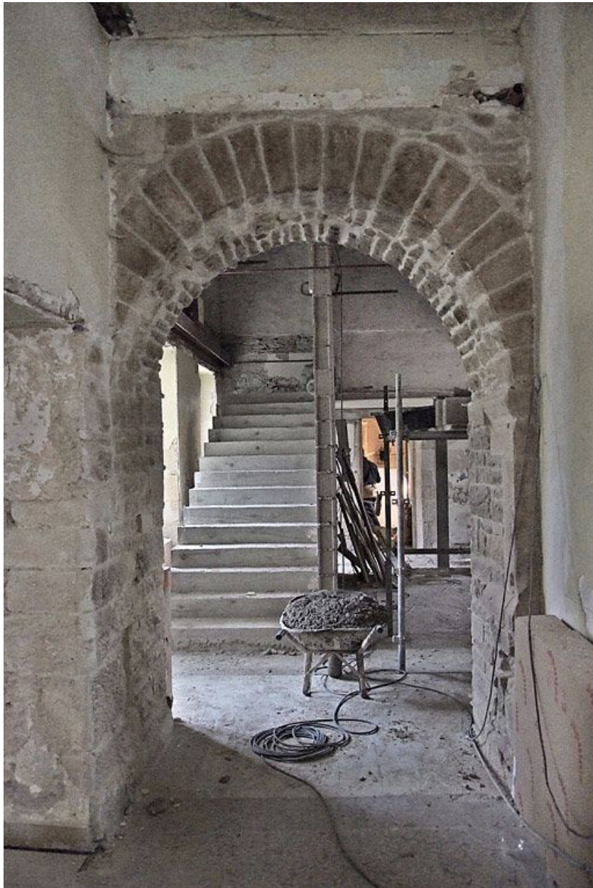
Couloir et escalier pendant les travaux.
