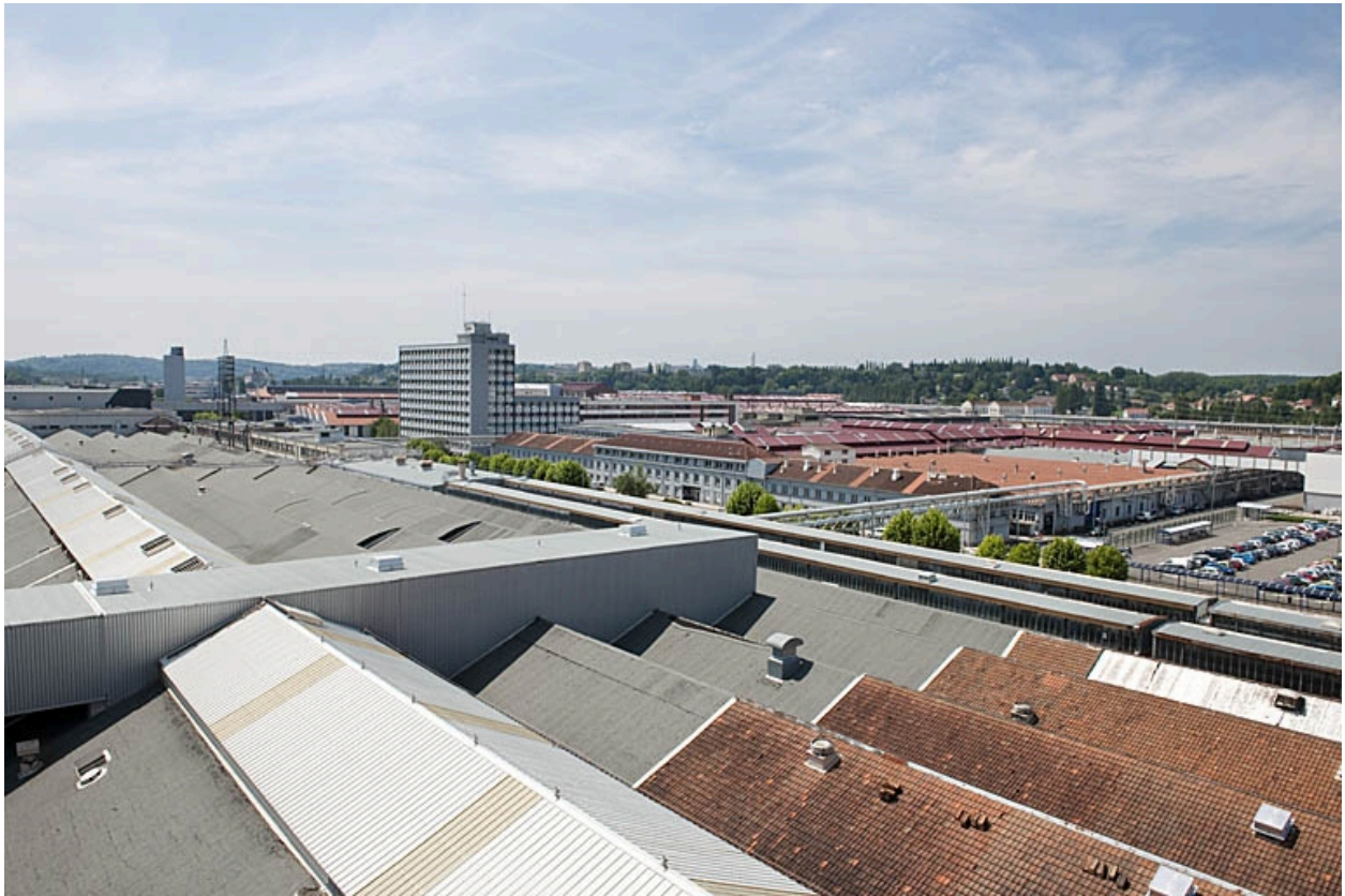
Vue d'ensemble depuis l'est du site.
