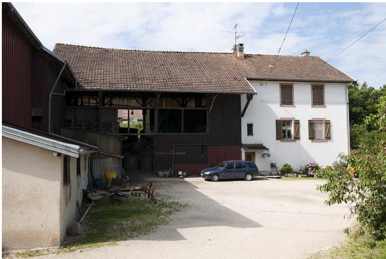
Second logement (extension ouest).
